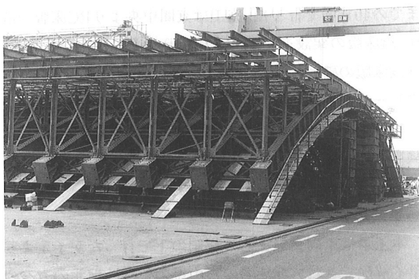
写真-1 仮組立状況
