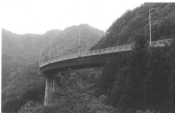
写真-3 曲線を強調したい場合には主桁のボルト継手部の見え方を利用した方が効果的な例
