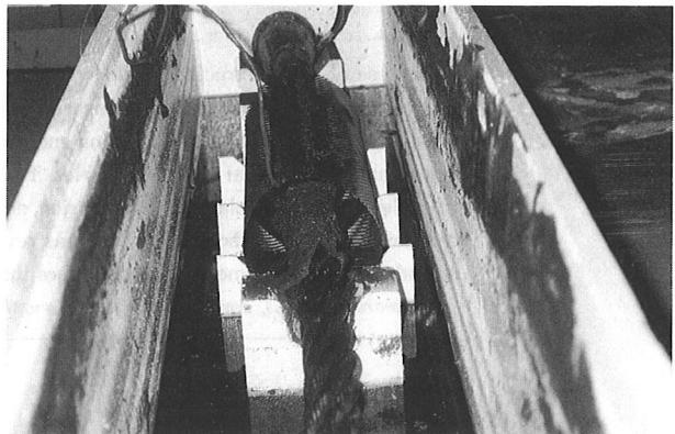
写真-1 銅製の電極の設置状況
