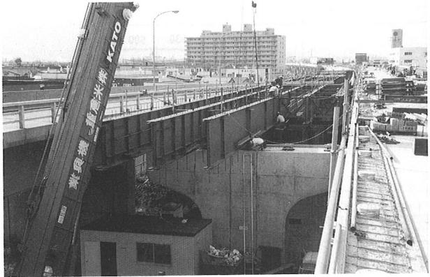
写真-3 鋼桁架設中
