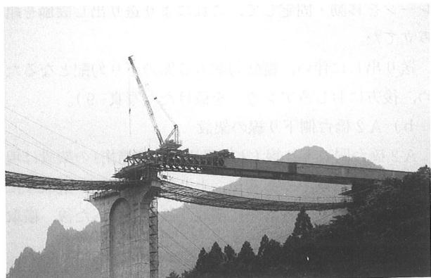
写真-8 ジブクレーンによる設備組立
