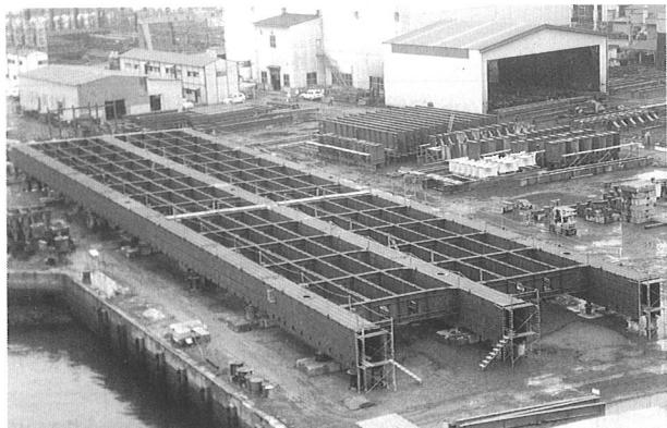
写真-4 補剛桁の仮組立
