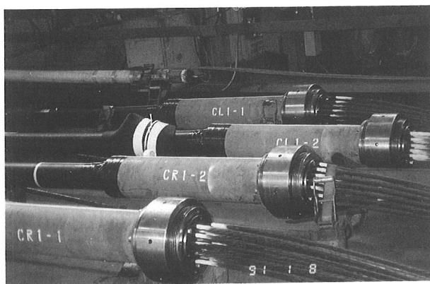
写真-6 緊張側斜材定着部
