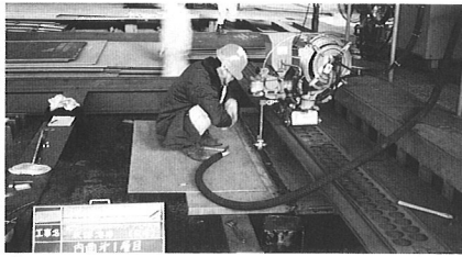
① 板継溶接
