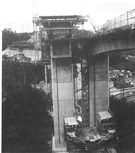
写真-6 型枠支保工の横取り
