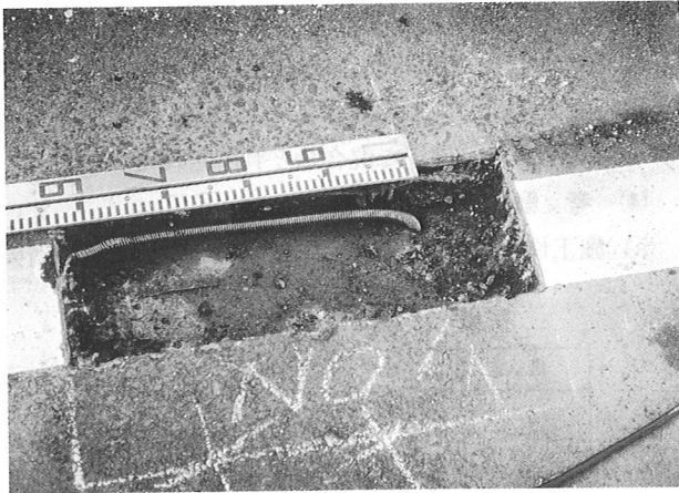
写真-5 埋設されていたドレイナーの状況
