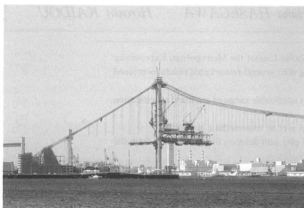
写真-10 中央径間の張出し架設
