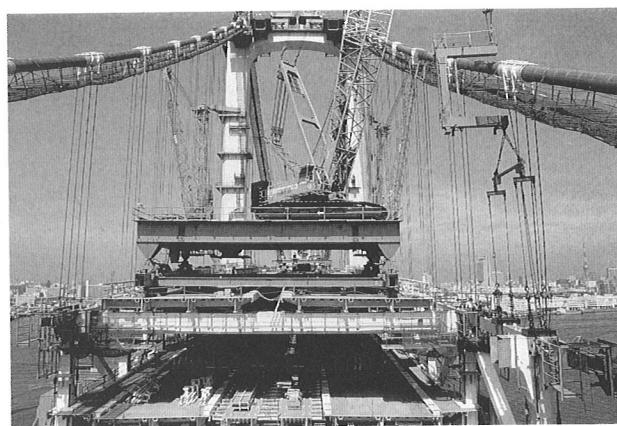
写真-8 コ字型天秤を用いた部材架設
