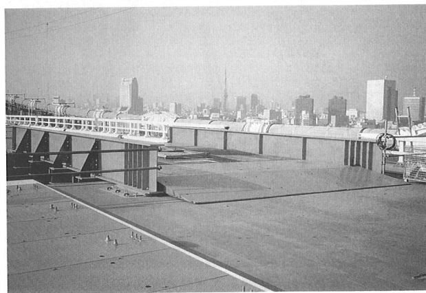
写真-9 中央ブロック鋼床版
