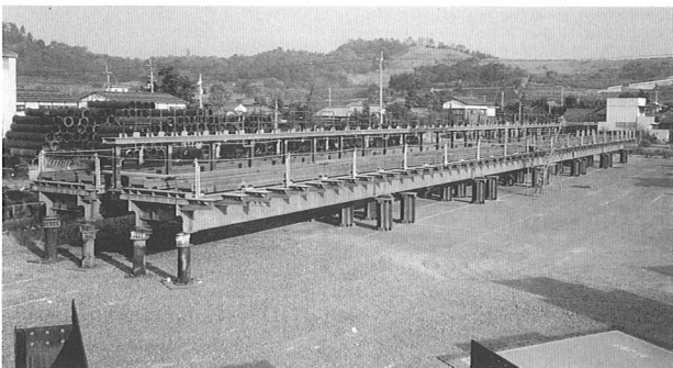
写真-5 新交通システム床組の仮組立
