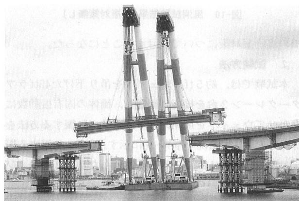
写真-8 Dブロックの架設状況
