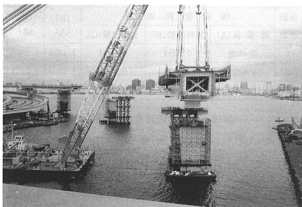
写真-7 Eブロックの架設状況
