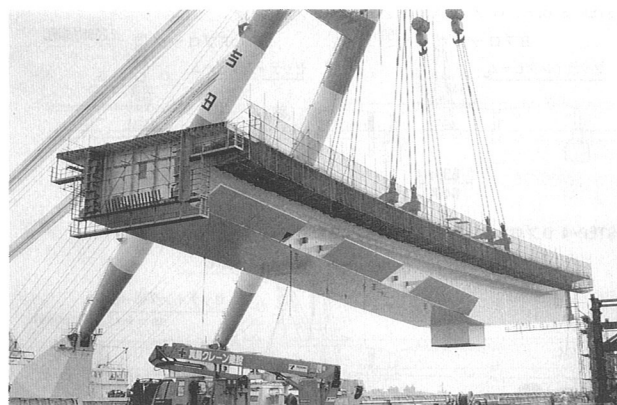
写真-4 大ブロックの浜出し
