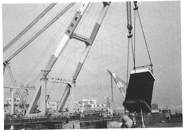
写真-5 P51橋脚の架設状況
