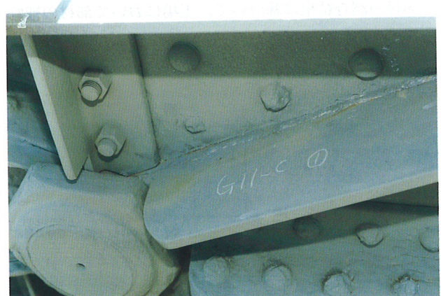
写真-3 アーチリブ支承部の補修状況 (左)補修前 (右)補修後
