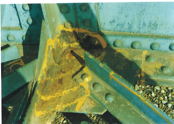
写真-4 対傾構取付け部の補修状況 (左)補修前 (右)補修後
