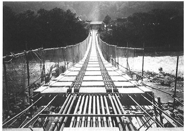
写真-1 プレキャスト床版架設完了
