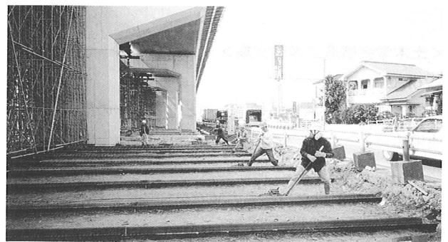
写真-2 横取り状況
