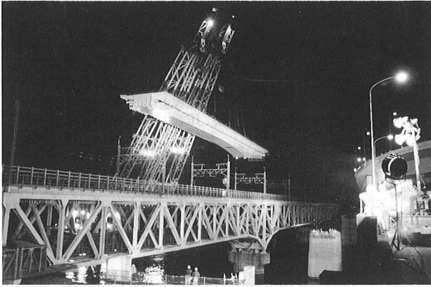
写真-2 架設風景 (JR京葉線上空)
