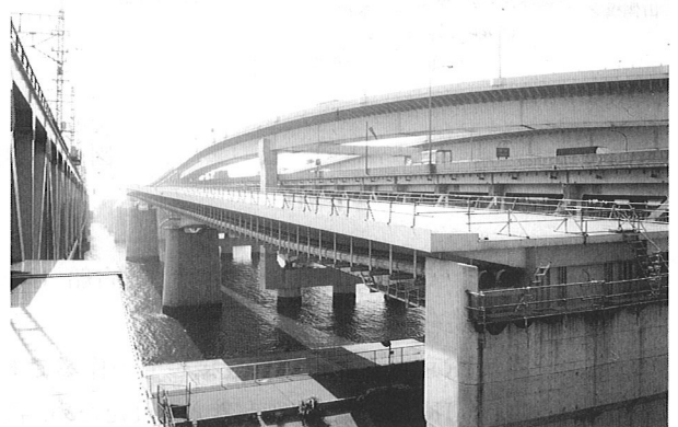
写真-1 完成風景
