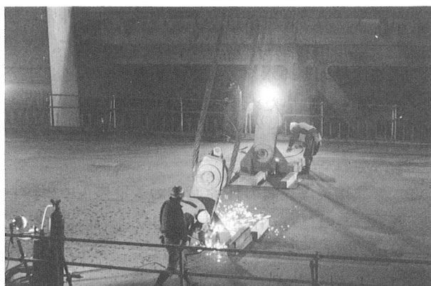
写真-5 吊金具のガス切断
