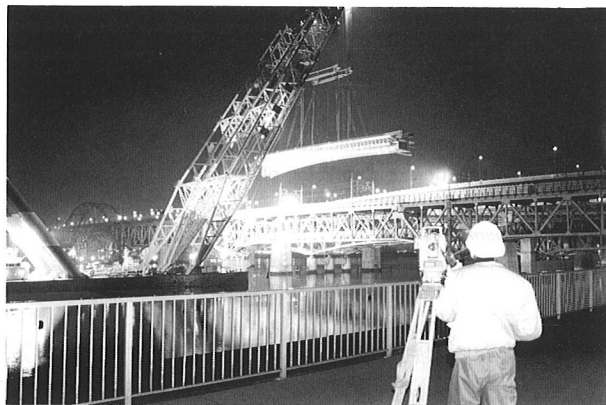
写真-7 トータルステーションを用いた計測状況
