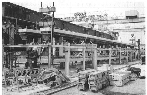
写真-1 プレフレクション作業全景
