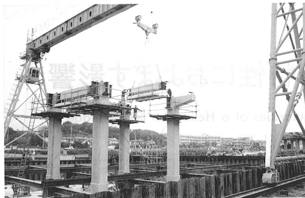
写真-2 柱梁組立状況
