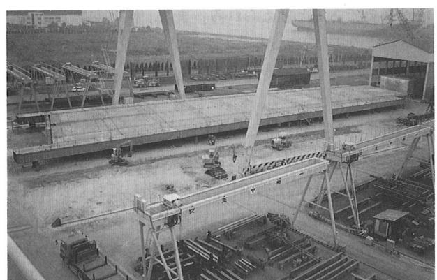
写真-2 仮組立状況（上層補剛桁、鋼床版）
