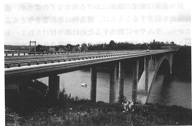
写真-4 海外における排水溝の例
