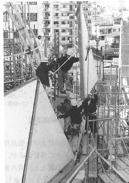
写真-5 パネルの架設
