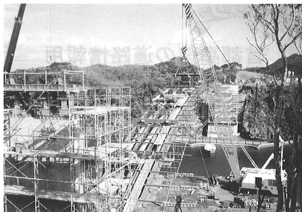
写真-1 アーチ架設
