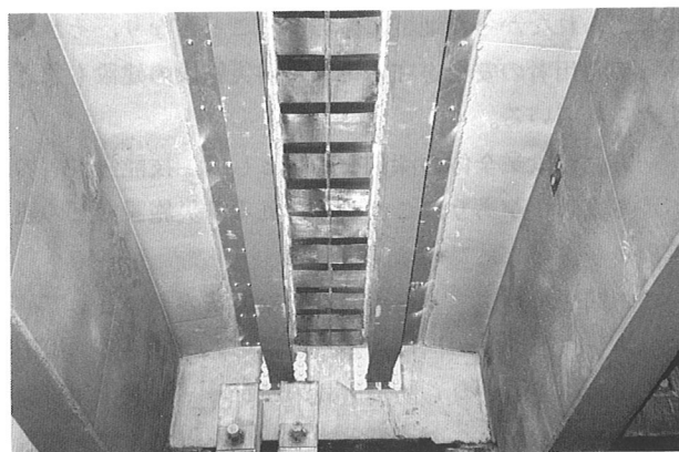
写真-2 床版下面の状況
