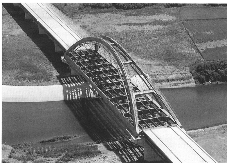
松原橋（仮称）全景
