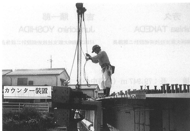
写真1 ウェブの取付け状況
