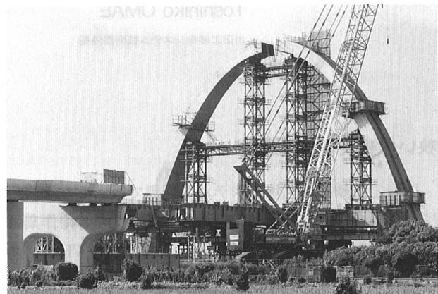
800t吊り大型クレーンによる架設
