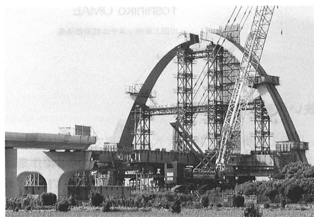
800 t吊り大型クレーンによる架設
