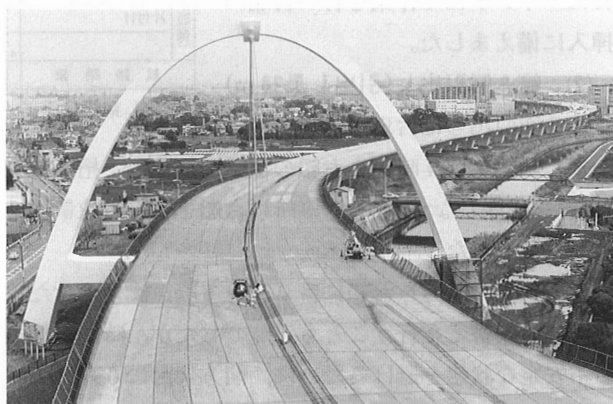
湘南ベルブリッジ全景
