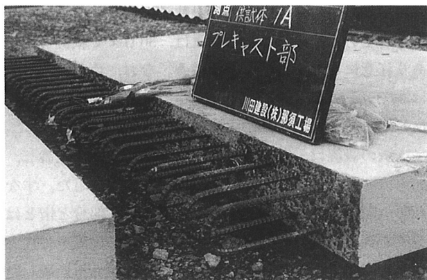
写真1 床版継ぎ目部分
