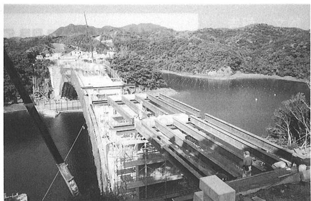
写真7 補剛桁支保工
