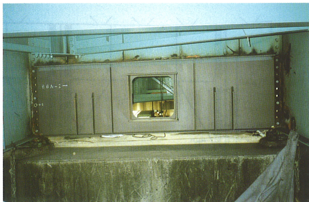
写真1 端横桁のフルウェブ化
