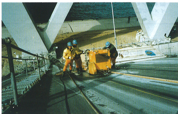
写真5 コンクリートカッター
