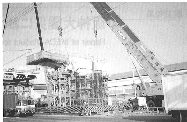
写真1 RC柱～鋼製梁複合橋脚
