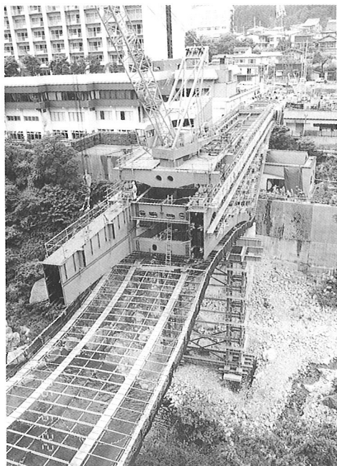
◀写真は上下ともトラベラークレーンによる張出し架設
