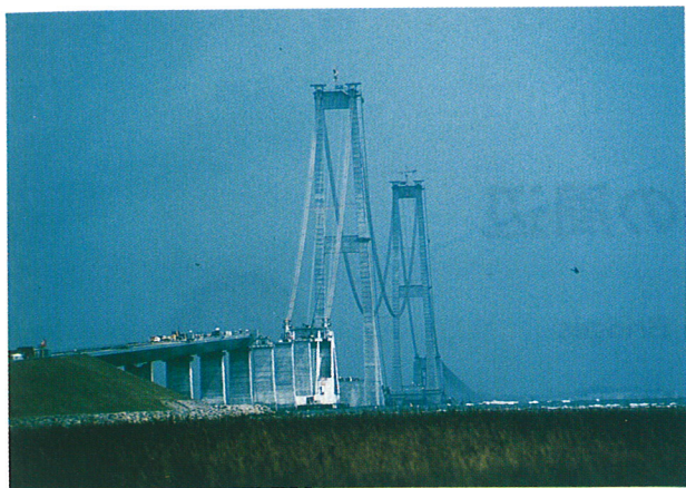
写真1 グレートベルト・イースト橋の建設状況
