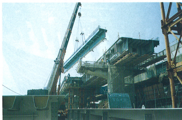
写真1 再構築桁の架設
