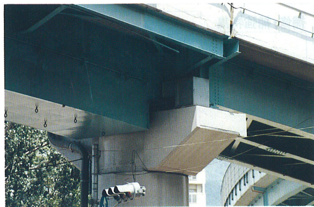
写真9 箱桁橋軸直角方向ストッパー
