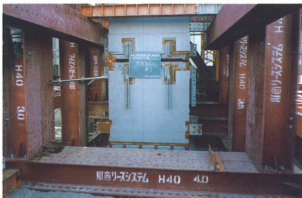
写真4 鋼製脚ブロック取替え
