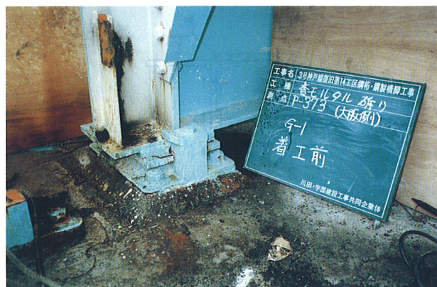
写真5 支承取替え前
