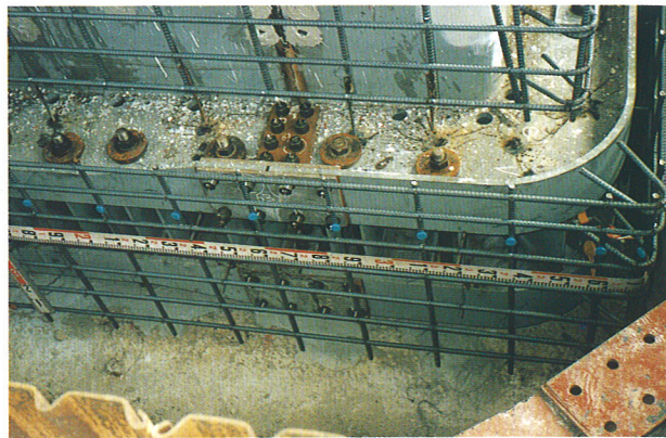
写真6 高力ボルト、アンカーボルトの設置
