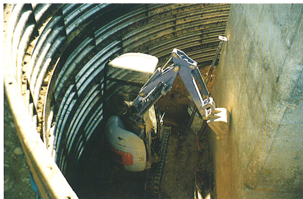
写真1 橋脚周辺における土砂の掘削および土留め
