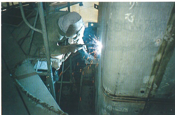
写真5 炭酸ガス半自動溶接を用いた現場溶接
