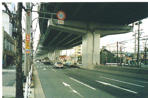
写真7 橋脚補強工事の完成風景
