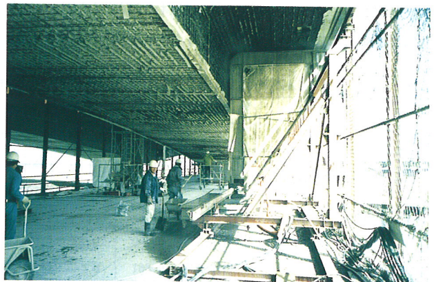
写真1 ウォータージェット装置によるはつり状況
