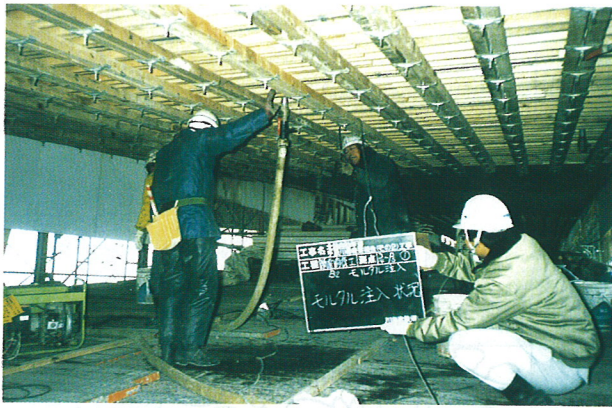
写真6 モルタル注入状況
