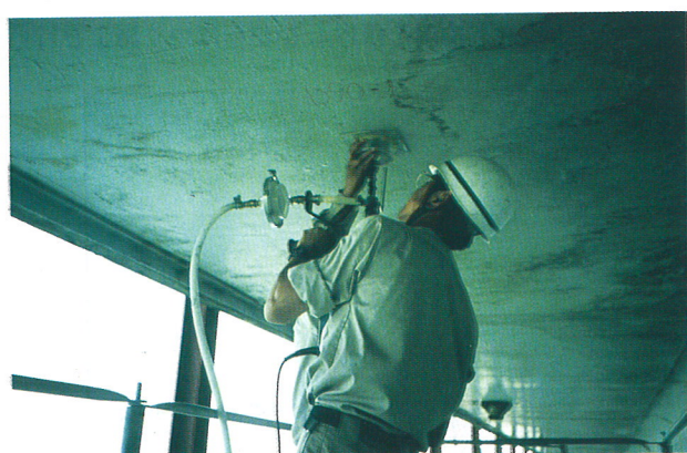
写真2 塩分調査状況
