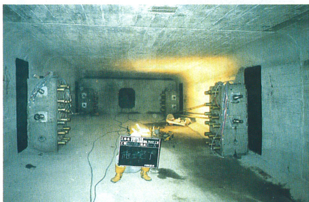
写真8 外ケーブル全景
