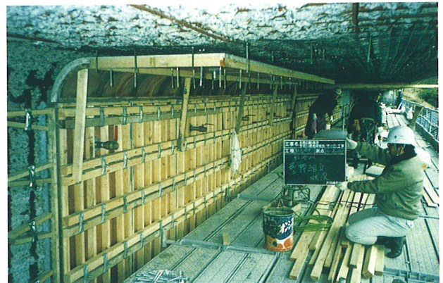
写真5 断面修復工状況
