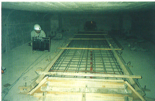
写真7 連続鋼材の配置状況
