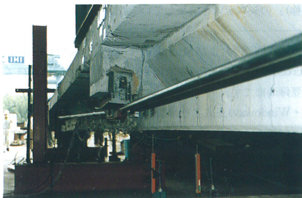
写真1 外ケーブル配置状況
