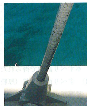
本橋ケーブル
