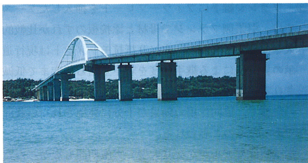
瀬底大橋全景
