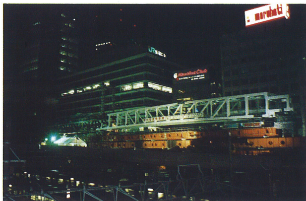
図1 架設系 本体桁
