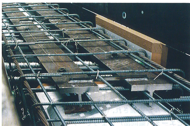
圧縮鋼材（内力移行を考慮し、SM490材使用）
