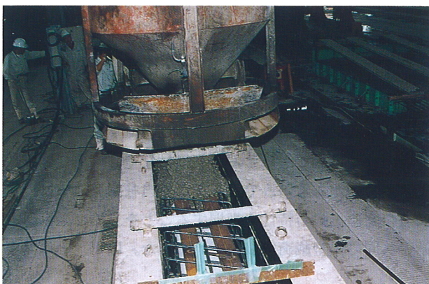
打設状況（二割鋼板のため、打設は簡便）
