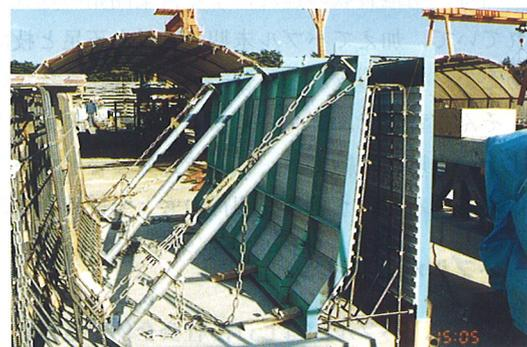
写真2 サポートおよび下部セパレータの取り付け
