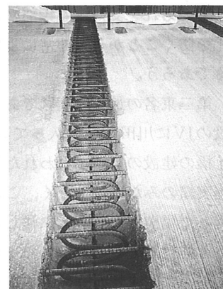
プレキャスト床版間のループ継手 (この後、ループ内に通し筋を配筋)
