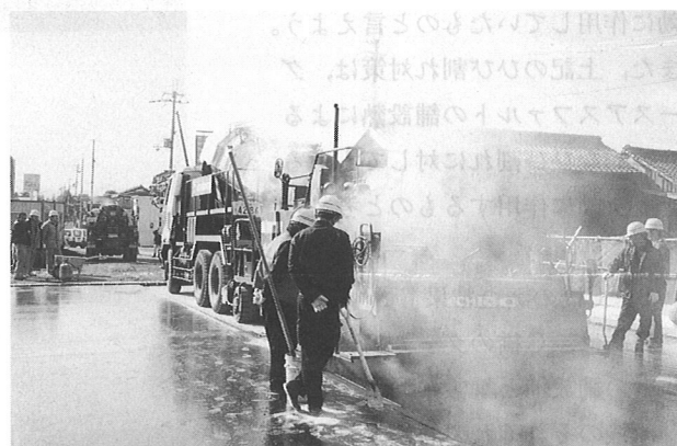
写真5 グースアスファルト舗設状況
