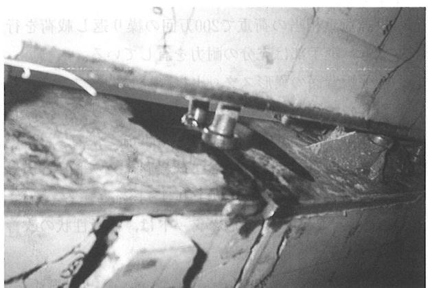
写真3 補強板の疲労亀裂部
