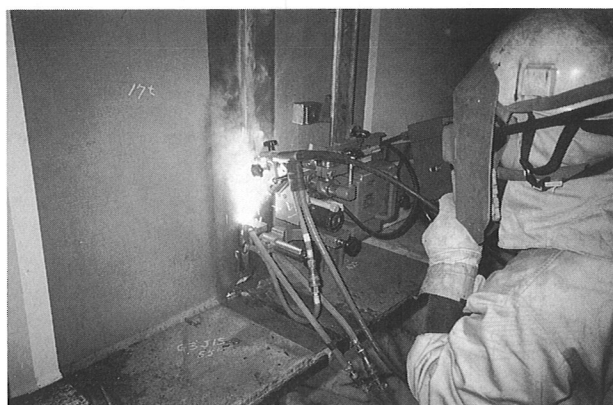
写真3 エレクトロガスアーク溶接
