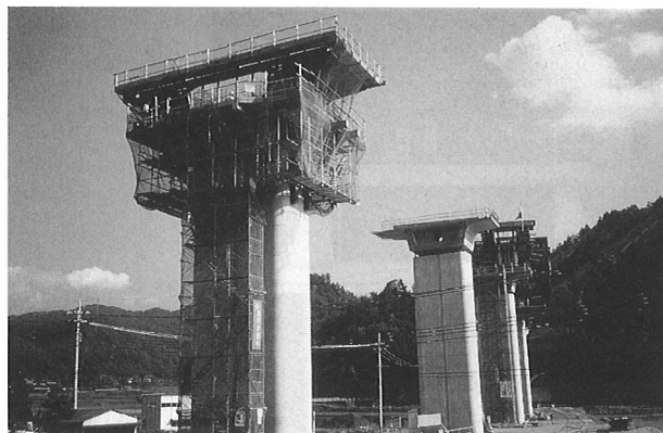
写真5 柱頭ブロック
