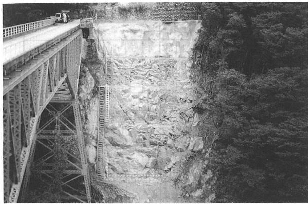
写真2 橋台掘削状況
