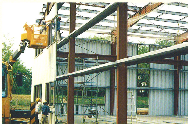
写真8 外壁材取付け
