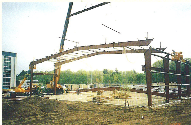
写真7 ブロック工法による鉄骨建方
