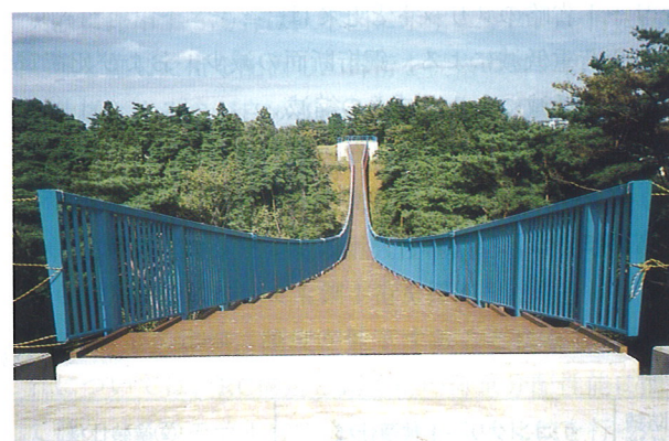
高欄・木床版架設完了時
