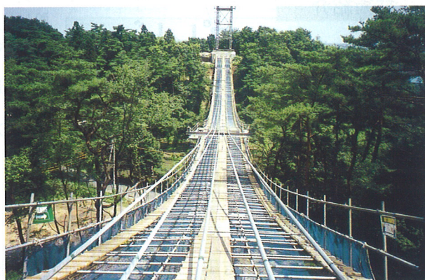
主ケーブル架設時
