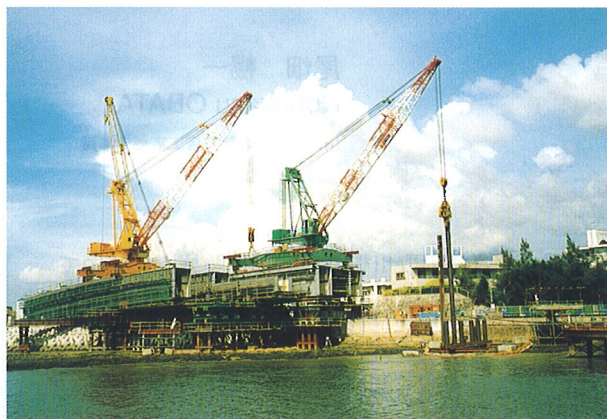
トラベラクレーンによる併行架設
