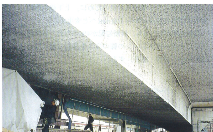
WJ工法によるはつり面
